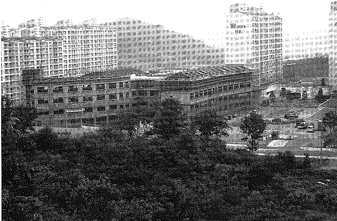
건설중인 만수초등학교 전경
