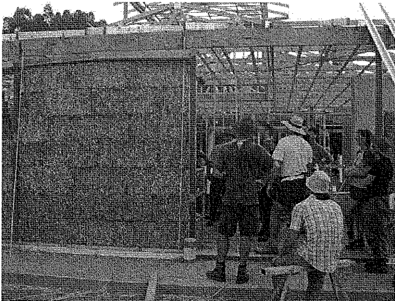
〈사진 6〉 목구조 사이에 베일을 다 쌓은 모습
